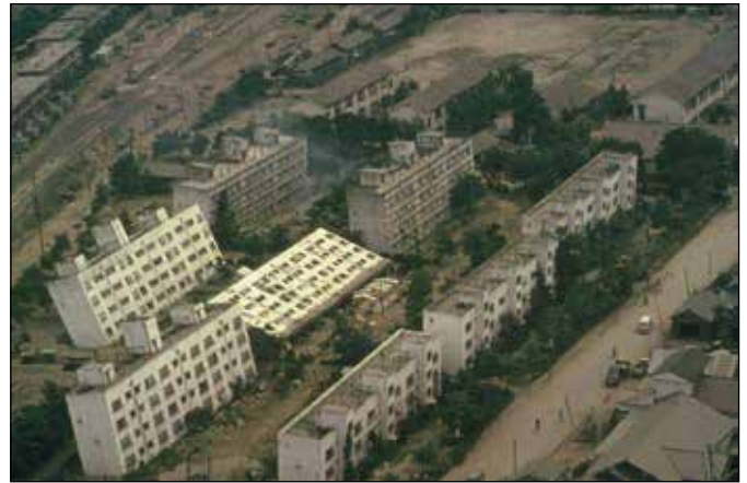
Рисунок 5 – Разжижение грунтов 16 июня 1964 года, Ниигата, Япония, M_{max} = 7,5 (Фото: Joseph Penzien)
