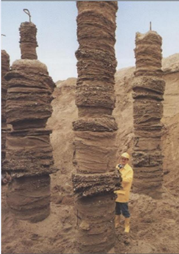
Струйная цементация jet-grouting
