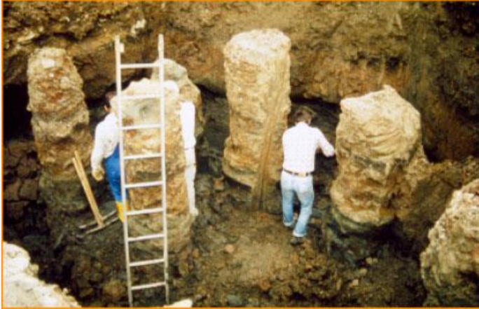
Технология Jet Grouting
