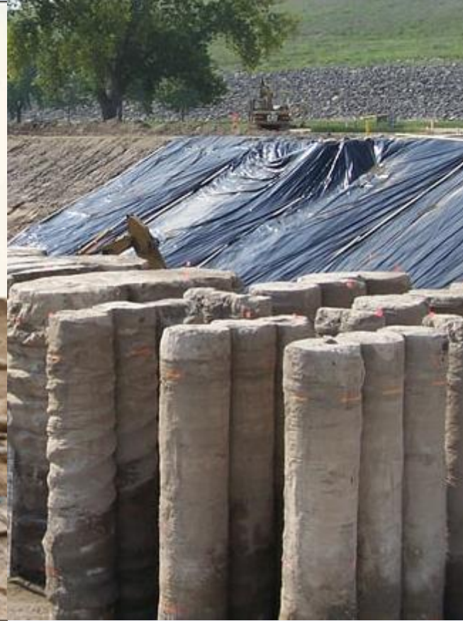
Глубинное перемешивание грунта DSM
