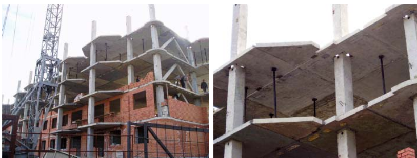
Рис.1. Жилой дом в конструкциях «КУБ-2,5» (г.Горно-Алтайск)
