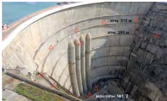
Рис.1. Внешний вид высотной плотины Чиркейской ГЭС с размещением основных пунктов регистрации (треугольники)
