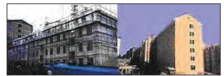
Рис. 3. Возведение монолитного дома
