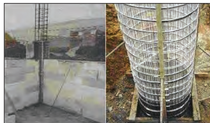
Рис. 6. Возведение колон каркаса (справа) и подземных колодцев (слева)
