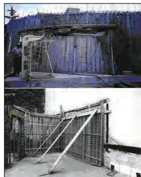
Рис. 5. Устройство плотины (сверху) и пристройки (внизу)
