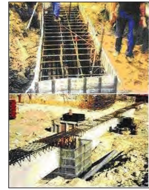
Рис. 2. Изготовление фундаментов из СНО
