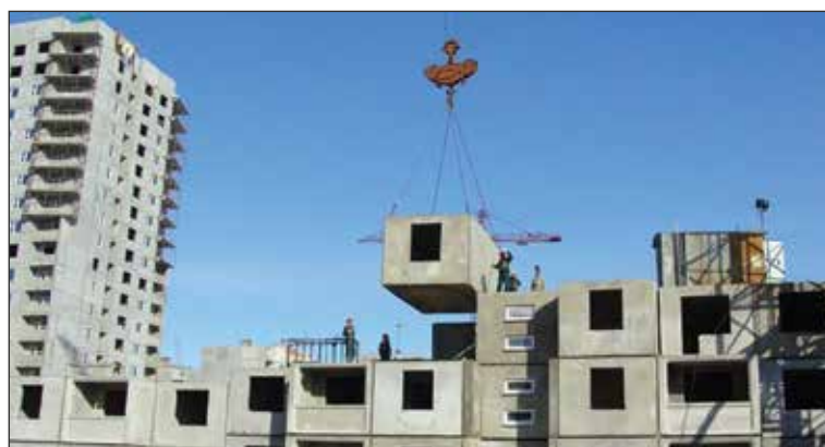
Рисунок 2 – Технология возведения объемно-блочных зданий
