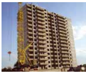
Рисунок 5 – Экспериментальный дом из конструкций ЗАО «ОБД» в г. Краснодаре
