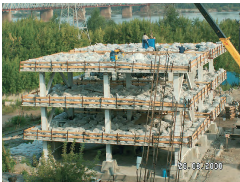
Рис.3. Испытания 3-этажного фрагмента здания системе «КБК». Пермь, 2008
