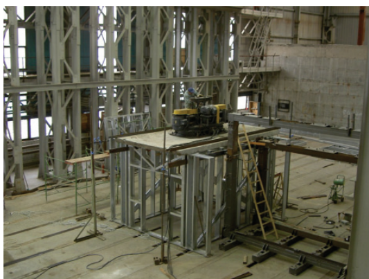
Рис.9. Испытание фрагмента здания с применением вибромашины ВИД-12
