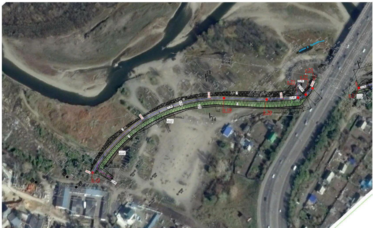
Рисунок 7 – Расположение защитной дамбы участок от т. 18 до т. 23 на космоснимке по состоянию на конец 2014 года
