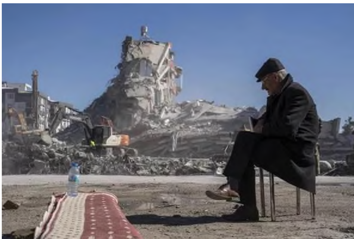
Рис. 2. Турция, г. Нурдагы (до и после землетрясения).
