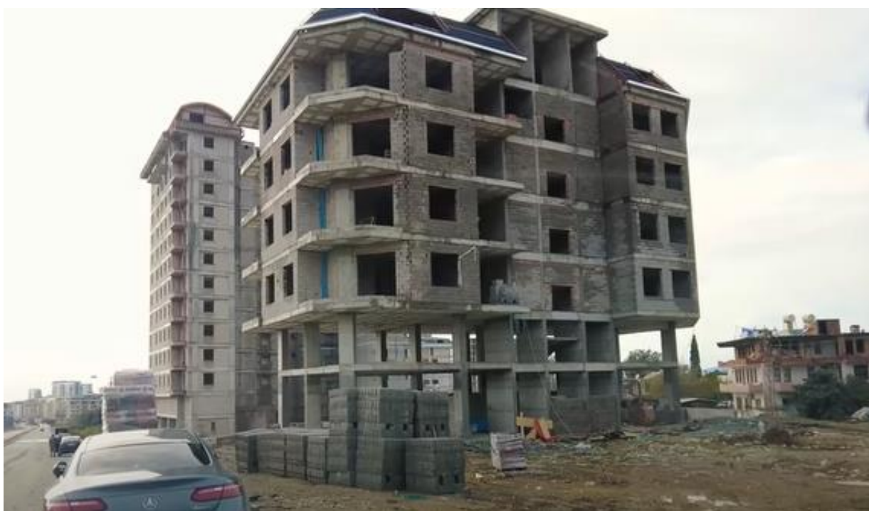
Рисунок 13 – Характерные для Турции недостатки объемно-планировочных и конструктивных решений при строительстве зданий
