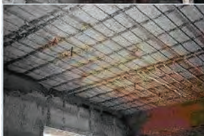
Рис.4. Устройство перекрытий и балок
