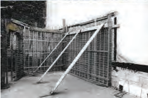
Рис.5. Устройство плотины (сверху) и пристройки (внизу)
