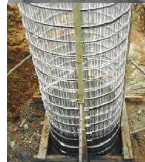
Рис.6. Возведение колон каркаса (сверху) и подземных колодцев (внизу)
