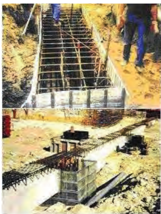
Рис.2. Изготовление фундаментов из СНО
