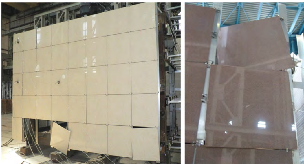
Рисунок 5 – Характерные повреждения НВФС при динамических нагрузках (облицовка из керамогранитных плит)
